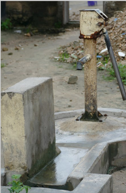
Typische Schwengelpumpe, Tansania, Foto: Helmut Jäger, 2024
